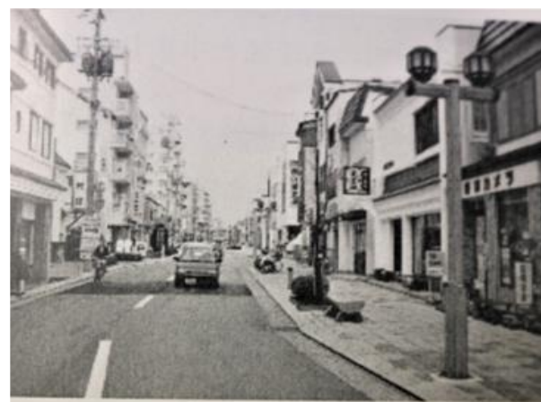
完成後 平成5～7年
