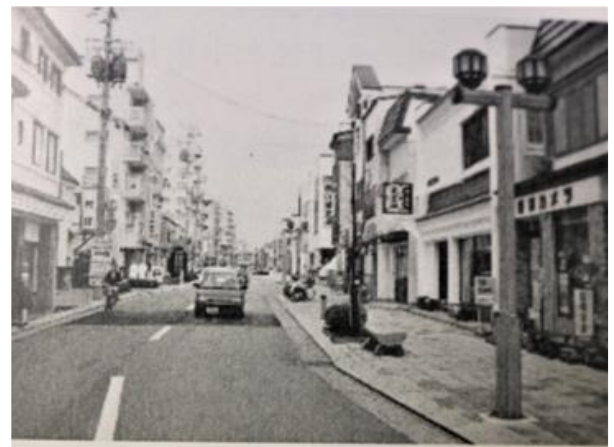
完成後 平成5~7年
